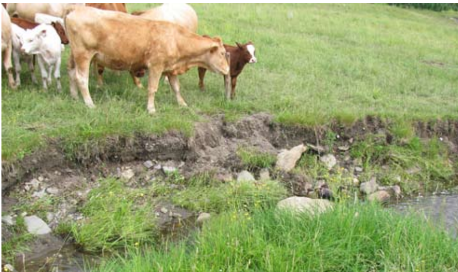
Problématique d'érosion des berges et accès direct des animaux aux cours d'eau.
