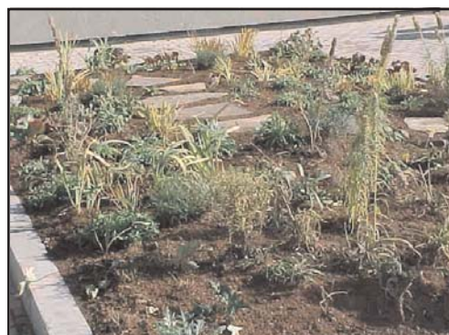
Jardin de toit semi-extensif sur le toit de l'hôtel de ville de Toronto (source : www.peck.ca/grhcc/overviewdemo.htm )
